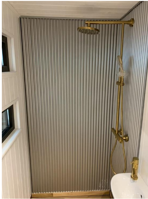
Dusjhjørneveggflate er i rustfritt stål Designprofil Design Venice 10.
